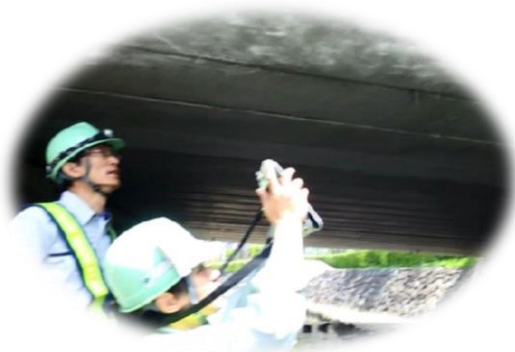
【タブレットによる点検】
