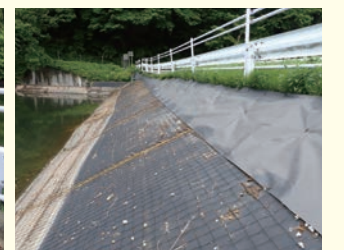
▲救助ネット施工例
