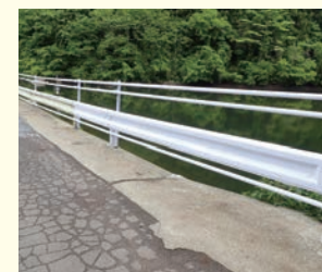
▲侵入防止柵施工
